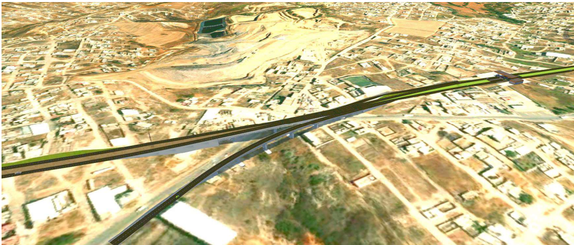
Figura 21. Entronque sobre estructura en el km 11+330. Fuente: DTP Consultores 2022
