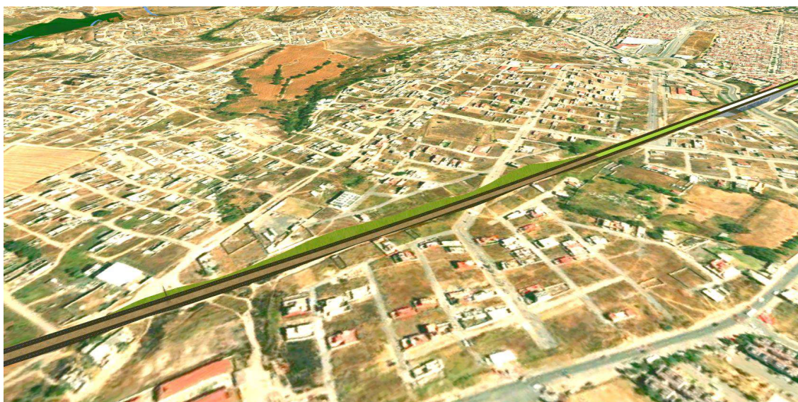
Figura 23 Zona de terracerías (Cortes) del km 11+900 al km 12+850. Fuente: DTP Consultores 2022
