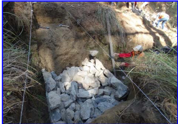
FOTOS IV.2.2.13 Y IV.2.2.14. VISTA DEL AVANCE DE LAS OBRAS MEDIANTE EL ACOMODO DEL MATERIAL ROCOSO, EN LA CUAL SE OBSERVA LA CONFORMACIÓN DE LA BASE DE LA PRESA
