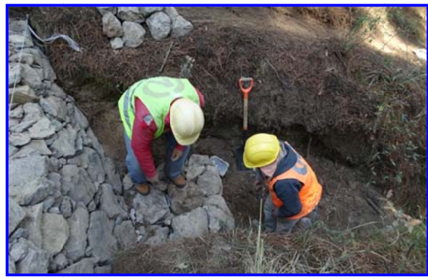
FOTOS IV.2.2.15 Y IV.2.2.16. ACOMODO DE LA BASE DE LA PRESA Y DEL COLCHÓN RESPECTIVAMENTE Y CONFORMACIÓN DE LA BASE DE LA PRESA ASÍ COMO DE LA CORTINA O DELANTAL DE LA PRESA
