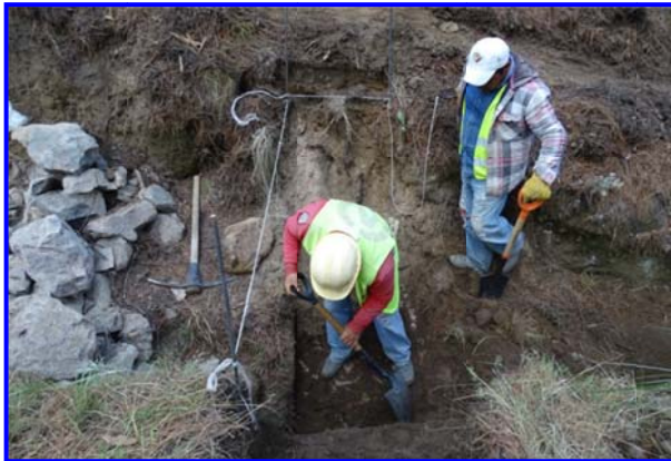
FOTOS IV.2.2.7 Y IV.2.2.8. EXCAVACIÓN DEL SITIO DONDE QUEDARA CONSTRUIDA LA PRESA, LO CUAL LES PERMITE EMPOTRAR EL MATERIAL ROCOSO EN LAS PAREDES Y EN EL PISO
