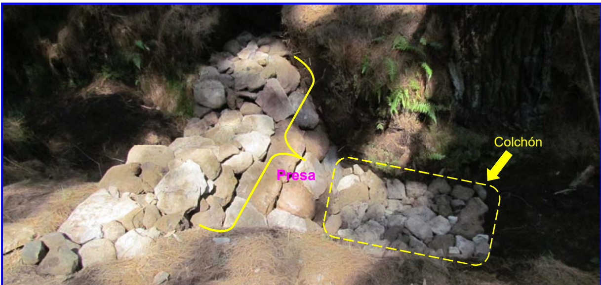
FOTO IV.2.2.26. ACERCAMIENTO DE LA CONDICIÓN FINAL DE LA PRESA CONSTRUIDA PARA FAVORECER LA INFILTRACIÓN DEL AGUA
