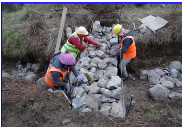
FOTOS IV.2.2.17 Y IV.2.2.18. AVANCE DEL EMPOTRAMIENTO DE LA PRESA Y CONFORMACIÓN DEL TALUD Y DEL VERTEDOR
