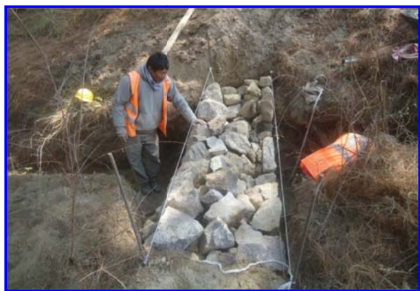
FOTOS IV.2.2.17 Y IV.2.2.18. AVANCE DEL EMPOTRAMIENTO DE LA PRESA Y CONFORMACIÓN DEL TALUD Y DEL VERTEDOR
