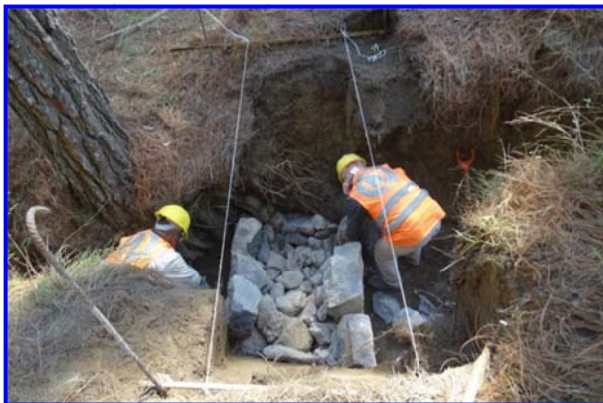
FOTOS IV.2.2.9 Y IV.2.2.10. ACOMODO DEL MATERIAL ROCOSO DENTRO DE LA CÁRCAVA A FIN DE ESTABLECER LA PRESA
