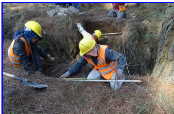
FOTOS IV.2.2.3 Y IV.2.2.4. NIVELACIÓN DE LAS PAREDES PARA ESTABLECER MEDIDAS DE ALTURA Y ANCHO DE LA PRESA
