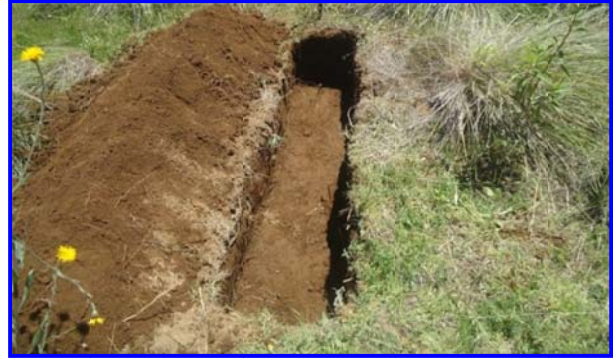
FOTOS IV.2.2.38 y IV.2.2.39. VISTA GENERAL Y ACERCAMIENTO AL TERMINAR LA REALIZACIÓN DE TINAS CIEGAS DEJANDO DE UNA MEDIDA PROMEDIO RECOMENDABLE DE 2 METROS DE LARGO, 40 CM DE ANCHO, 40 DE PROFUNDIDAD
