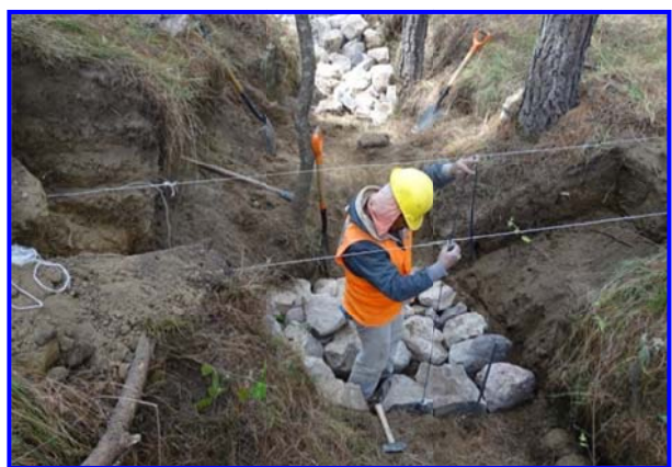
FOTOS IV.2.2.11 Y IV.2.2.12. USO DEL PLOMO PARA ESTABLECER LA NIVELACIÓN DE LA OBRA Y MEJORAR SU EMPOTRAMIENTO DE ACUERDO A LO ESTABLECIDO EN LA CAPACITACIÓN
