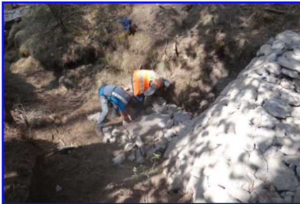
FOTOS IV.2.2.21 Y IV.2.2.22. ACOMODO DE PIEDRA PARA REALIZAR EL VERTEDOR Y VISTA DEL ACOMODO DEL COLCHÓN DE LA PRESA
