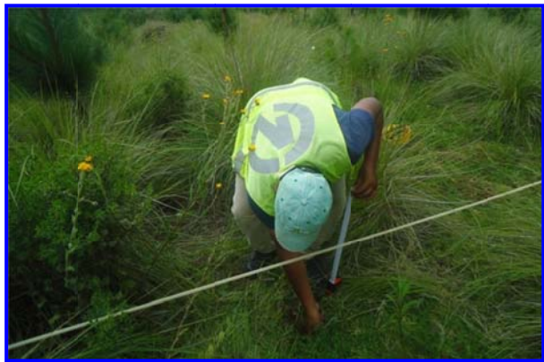
FOTOS IV.2.2.33 Y IV.2.2.34. TRAZO DE LÍNEA EN DONDE SE VAN MARCANDO LAS ÁREAS DE CONSTRUCCIÓN DE LAS ZANJAS, SIGUIENDO UNA CURVA DE NIVEL PREVIAMENTE TRAZADA
