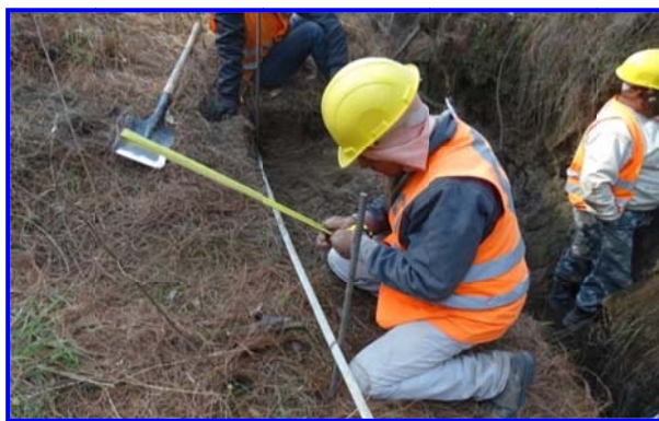
FOTOS IV.2.2.5 Y IV.2.2.6. ESCUADRA REALIZADA CON EL NIVEL DE MANGUERA PARA ESTABLECER LAS DIMENSIONES DE LA PRESA
