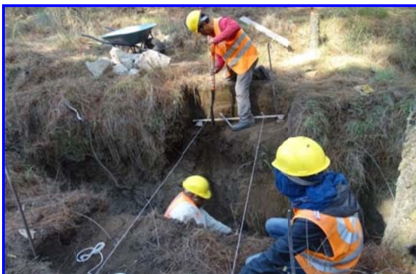
FOTOS IV.2.2.3 Y IV.2.2.4. NIVELACIÓN DE LAS PAREDES PARA ESTABLECER MEDIDAS DE ALTURA Y ANCHO DE LA PRESA
