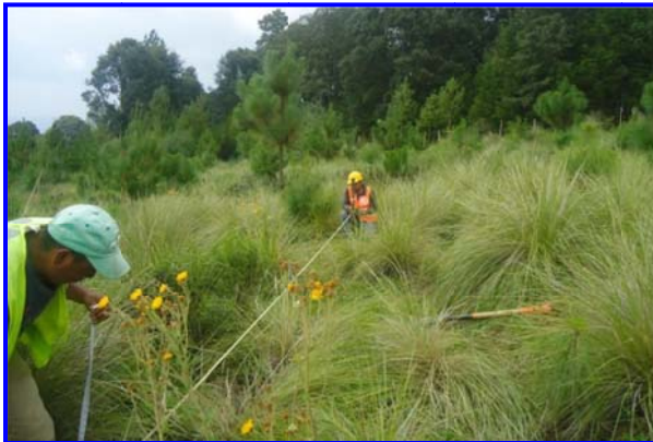
FOTOS IV.2.2.33 Y IV.2.2.34. TRAZO DE LÍNEA EN DONDE SE VAN MARCANDO LAS ÁREAS DE CONSTRUCCIÓN DE LAS ZANJAS, SIGUIENDO UNA CURVA DE NIVEL PREVIAMENTE TRAZADA
