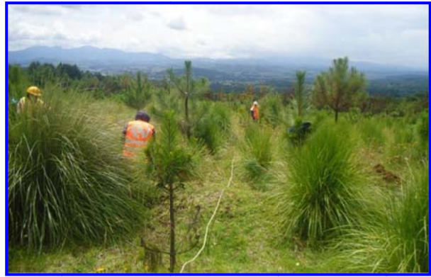
FOTOS IV.2.2.31 Y IV.2.2.32. BRIGADA AMBIENTAL REALIZANDO TRAZO DE LAS CURVAS DE NIVEL EFECTUADO MEDIANTE EL USO DE MANGUERA DE NIVEL
