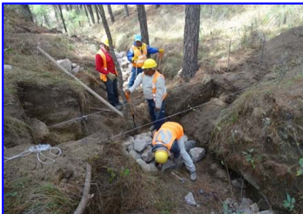
FOTOS IV.2.2.11 Y IV.2.2.12. USO DEL PLOMO PARA ESTABLECER LA NIVELACIÓN DE LA OBRA Y MEJORAR SU EMPOTRAMIENTO DE ACUERDO A LO ESTABLECIDO EN LA CAPACITACIÓN
