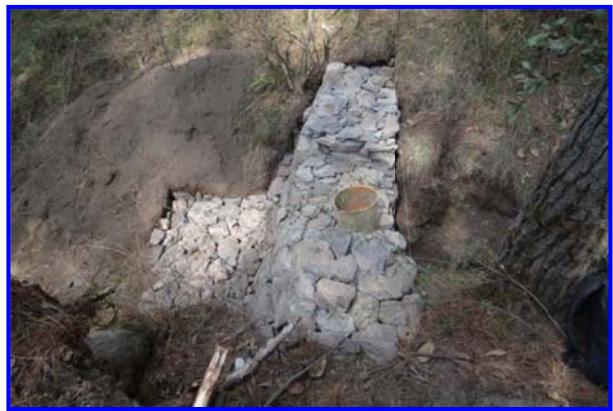
FOTOS IV.2.2.21 Y IV.2.2.22. ACOMODO DE PIEDRA PARA REALIZAR EL VERTEDOR Y VISTA DEL ACOMODO DEL COLCHÓN DE LA PRESA
