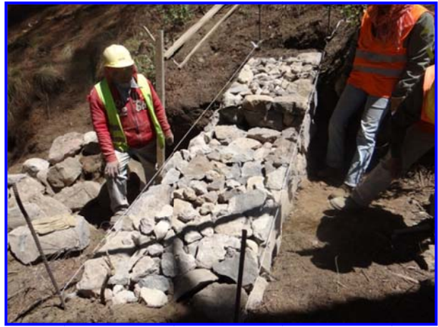
FOTOS IV.2.2.19 Y IV.2.2.20. PRESA YA CONFORMADA EN LA CUAL SE APRECIA EL VERTEDOR Y LA CORONA
