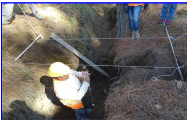
FOTOS IV.2.2.5 Y IV.2.2.6. ESCUADRA REALIZADA CON EL NIVEL DE MANGUERA PARA ESTABLECER LAS DIMENSIONES DE LA PRESA
