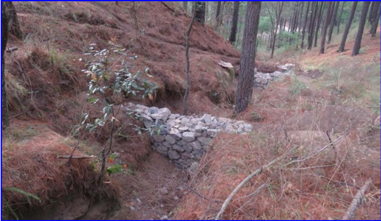
FOTO IV.2.2.25. PRESAS DE PIEDRA TERMINADAS, EN LAS CUALES SE PUEDE APRECIAR SU ESTABLECIMIENTO DE ACUERDO A LOS NIVELES DE (PIE-CABEZA) DENTRO DE LA CÁRCAVA
