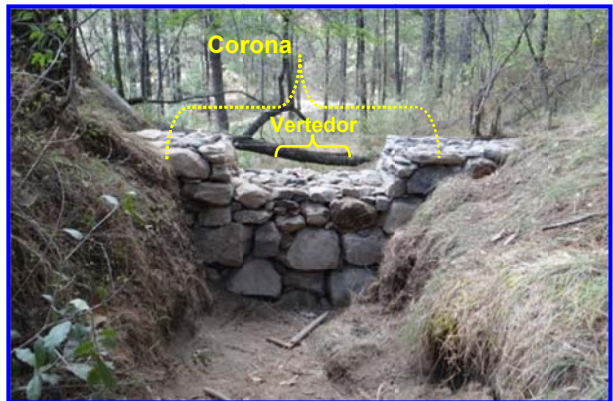
FOTOS IV.2.2.23 Y IV.2.2.24. VISTA DE LA PRESA TERMINADA AGUAS ABAJO Y AGUAS ARRIBA EN LA CUAL SE APRECIA EL COLCHÓN ASÍ COMO EL VERTEDOR
