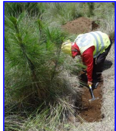
FOTOS IV.2.2.35, IV.2.2.36 Y IV.2.2.37. VISTA DE AVANCE DE LA REALIZACIÓN DE LAS ZANJAS TRINCHERAS FORMANDO UN BORDO DE UNA LONGITUD IGUAL A LA DE LA ZANJA Y COMPACTANDO PARA EVITAR QUE LA CORRIENTE ARRASTRE EL SUELO
