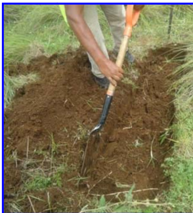
FOTOS IV.2.2.35, IV.2.2.36 Y IV.2.2.37. VISTA DE AVANCE DE LA REALIZACIÓN DE LAS ZANJAS TRINCHERAS FORMANDO UN BORDO DE UNA LONGITUD IGUAL A LA DE LA ZANJA Y COMPACTANDO PARA EVITAR QUE LA CORRIENTE ARRASTRE EL SUELO
