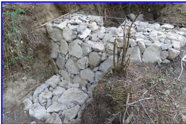
FOTOS IV.2.2.23 Y IV.2.2.24. VISTA DE LA PRESA TERMINADA AGUAS ABAJO Y AGUAS ARRIBA EN LA CUAL SE APRECIA EL COLCHÓN ASÍ COMO EL VERTEDOR
