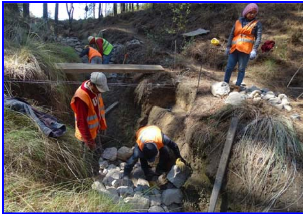
FOTOS IV.2.2.13 Y IV.2.2.14. VISTA DEL AVANCE DE LAS OBRAS MEDIANTE EL ACOMODO DEL MATERIAL ROCOSO, EN LA CUAL SE OBSERVA LA CONFORMACIÓN DE LA BASE DE LA PRESA
