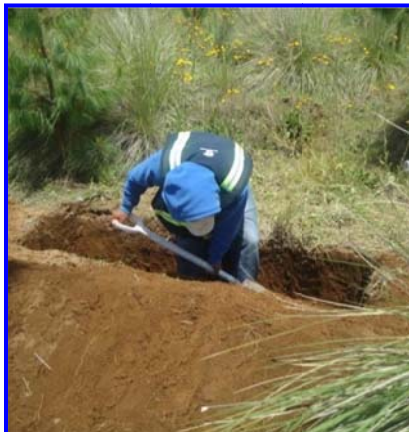
FOTOS IV.2.2.35, IV.2.2.36 Y IV.2.2.37. VISTA DE AVANCE DE LA REALIZACIÓN DE LAS ZANJAS TRINCHERAS FORMANDO UN BORDO DE UNA LONGITUD IGUAL A LA DE LA ZANJA Y COMPACTANDO PARA EVITAR QUE LA CORRIENTE ARRASTRE EL SUELO
