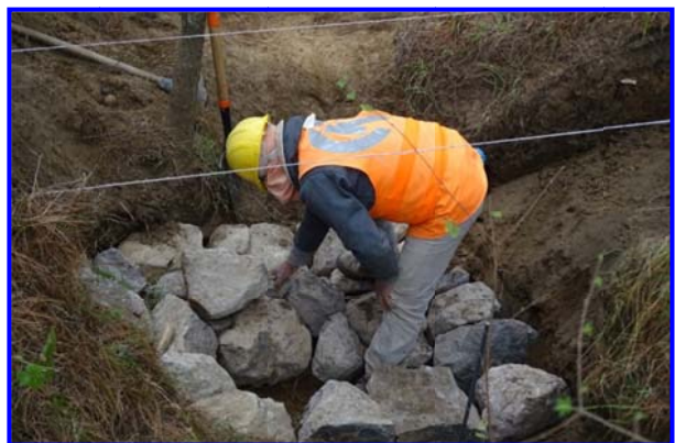
FOTOS IV.2.2.9 Y IV.2.2.10. ACOMODO DEL MATERIAL ROCOSO DENTRO DE LA CÁRCAVA A FIN DE ESTABLECER LA PRESA
