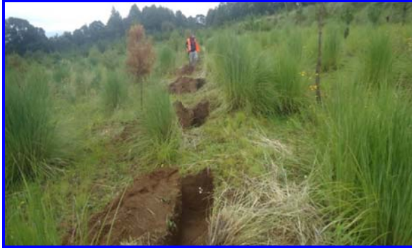
FOTOS IV.2.2.38 y IV.2.2.39. VISTA GENERAL Y ACERCAMIENTO AL TERMINAR LA REALIZACIÓN DE TINAS CIEGAS DEJANDO DE UNA MEDIDA PROMEDIO RECOMENDABLE DE 2 METROS DE LARGO, 40 CM DE ANCHO, 40 DE PROFUNDIDAD
