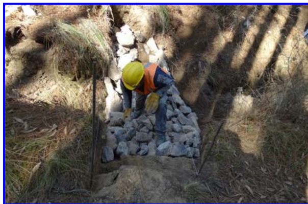
FOTOS IV.2.2.15 Y IV.2.2.16. ACOMODO DE LA BASE DE LA PRESA Y DEL COLCHÓN RESPECTIVAMENTE Y CONFORMACIÓN DE LA BASE DE LA PRESA ASÍ COMO DE LA CORTINA O DELANTAL DE LA PRESA
