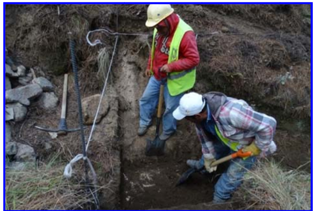
FOTOS IV.2.2.7 Y IV.2.2.8. EXCAVACIÓN DEL SITIO DONDE QUEDARA CONSTRUIDA LA PRESA, LO CUAL LES PERMITE EMPOTRAR EL MATERIAL ROCOSO EN LAS PAREDES Y EN EL PISO
